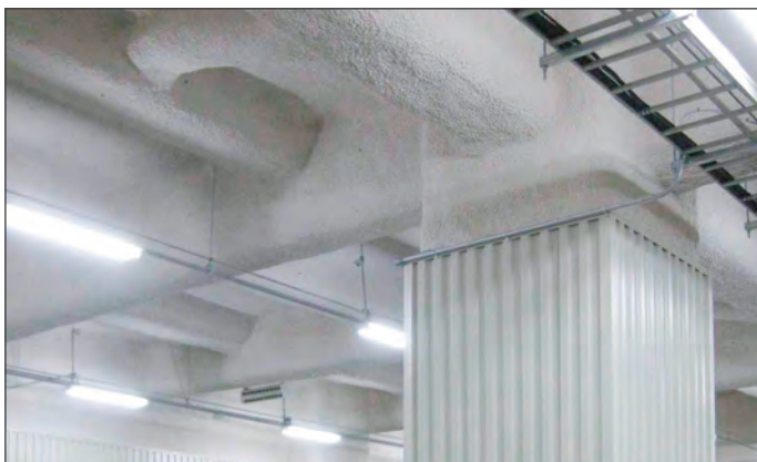
冷凍冷蔵庫部の内部・エレベーターシャフト部
