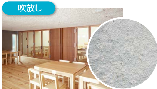
▲スラブに吹放し仕上げ
