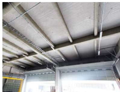
トラックバースのスラブ面
