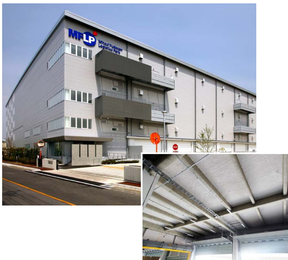
MFLP 八潮 (埼玉県) 施工部位: トラックパースのスラブ (吹放し)
