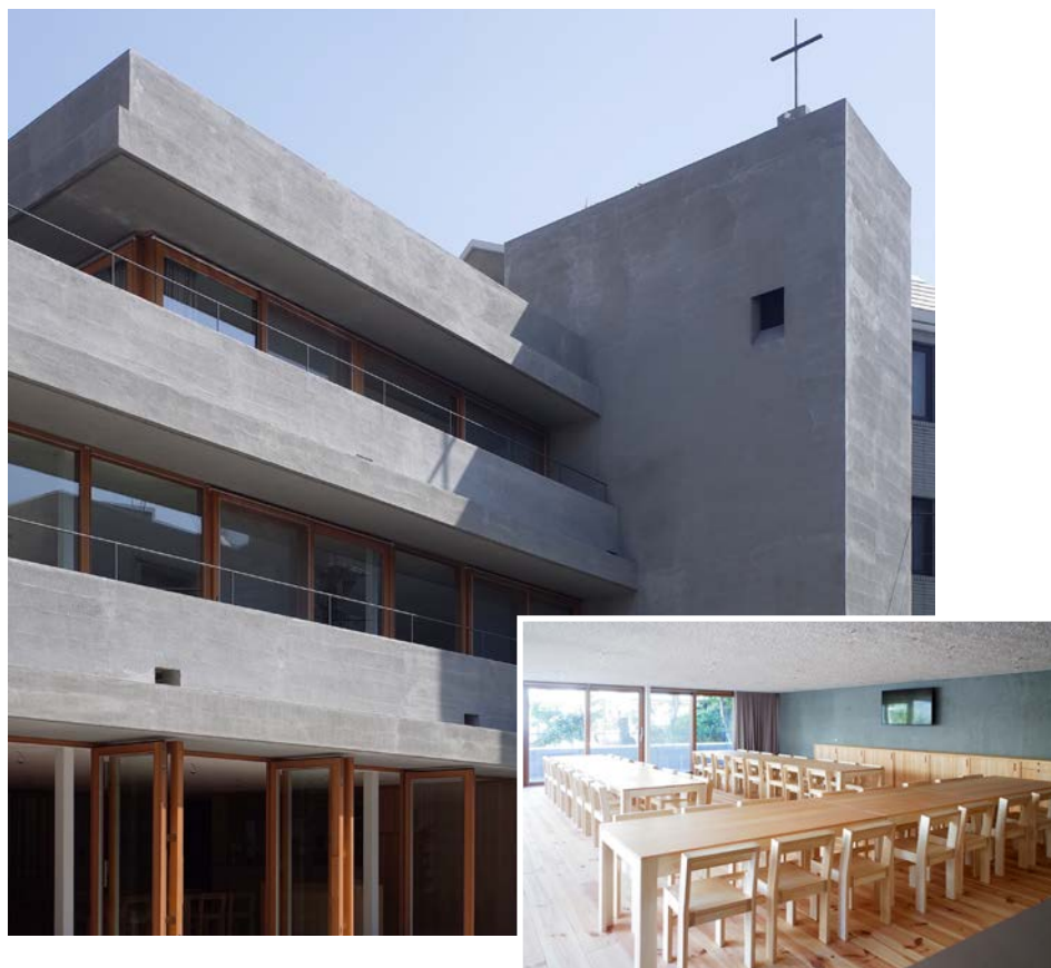
日本キリスト教団 番町教会 (東京都) 施工部位: 屋内のスラブ (吹放し)
