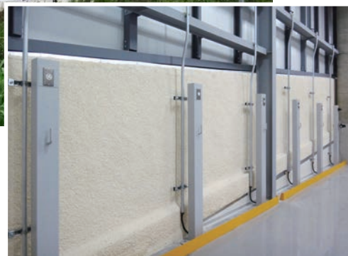
施工部位:車路の壁(吹放し)
