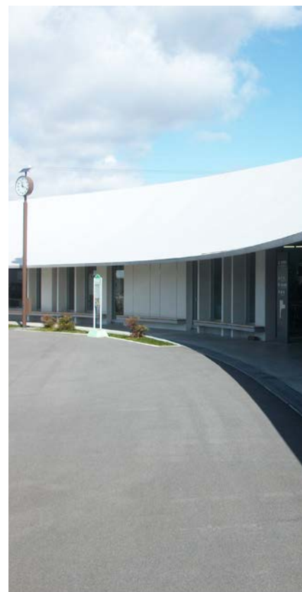
岐南町庁舎 (岐阜県) 施工部位: 屋内
