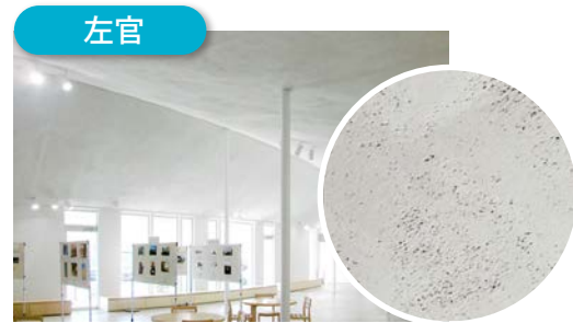
▲スラブにてこ押さえ仕上げ
