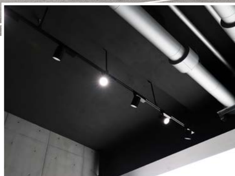
三木山総合公園(兵庫県) 施工部位:準屋外通路のスラブ(こて押さえ+着色)
