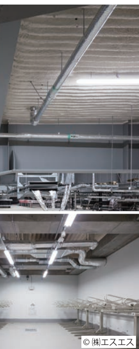
施工部位：駐輪場デッキスラブ (吹放し)
