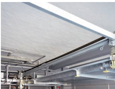
マンションの立体駐車場のスラブ面
