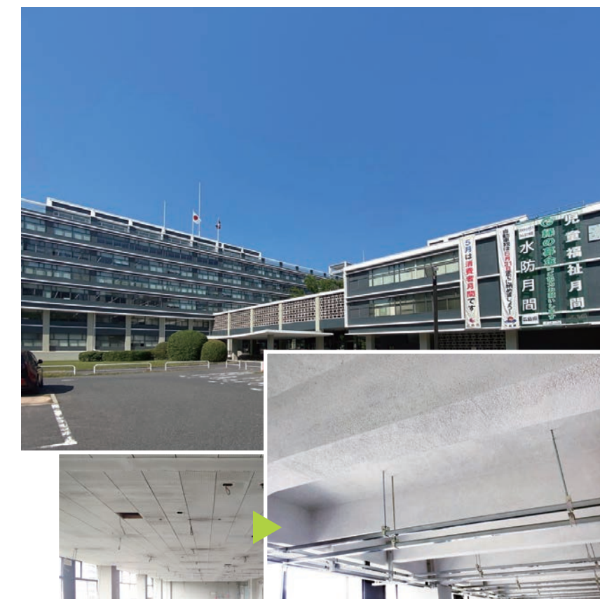
広島県庁舎 [改修] (広島県) 施工部位: 屋内のスラブ (こて押さえ) 施主: 広島県 設計: 株式会社日建設計・株式会社近代設計コンサルタント設計共同体 施工: 大成建設・増岡組・大之木建設広島県庁舎本館等耐震改修及び維持保全工事共同企業体
