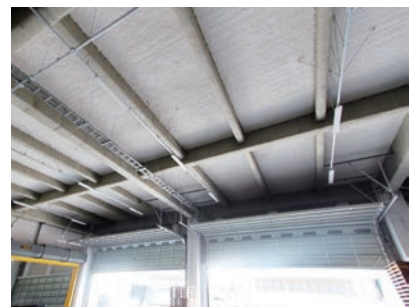
トラックバースのスラブ面
