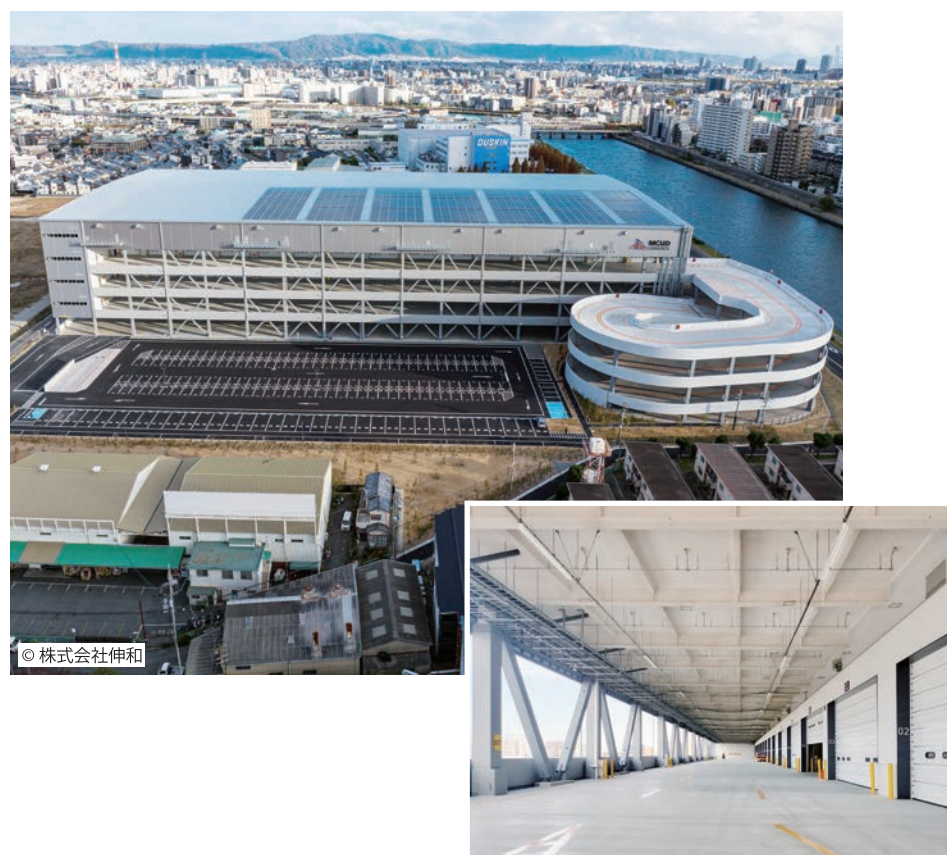
MCUD南吹田 (大阪府) 施工部位: 車路のスラブ (吹放し) ※準屋外仕様、梁はセラタイカ2号* 施主: 三菱商事都市開発株式会社・株式会社サンケイビル 設計: 西松建設株式会社 施工: 西松建設株式会社 *セラタイカ2号については、別途専用パンフレットをご参照ください。
