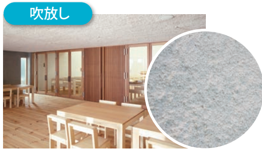
▲スラブに吹放し仕上げ
