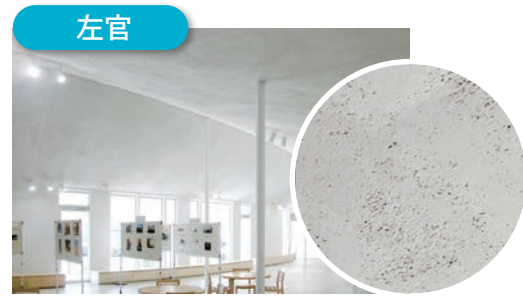
▲スラブにてこ押さえ仕上げ
