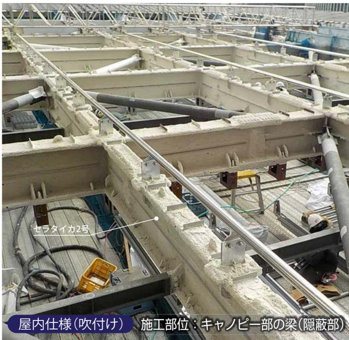
屋内仕様(吹付け) 施工部位：キャノピー部の梁(隠蔽部)
