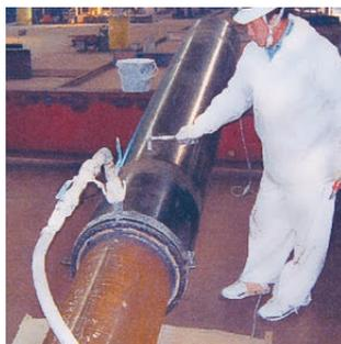
⑥ 材料の注入孔から吐出後、木栓を設置。
