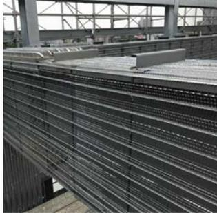
② セラタイカ 2号を下塗りし、コーナービートを取付けた後、セラタイカ 2号を規定厚みまで塗布する。
