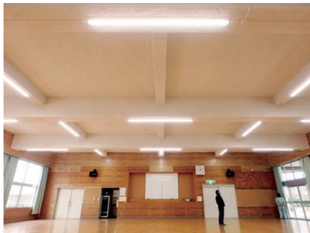
天井／不燃断熱（ダンセラボン #25）
