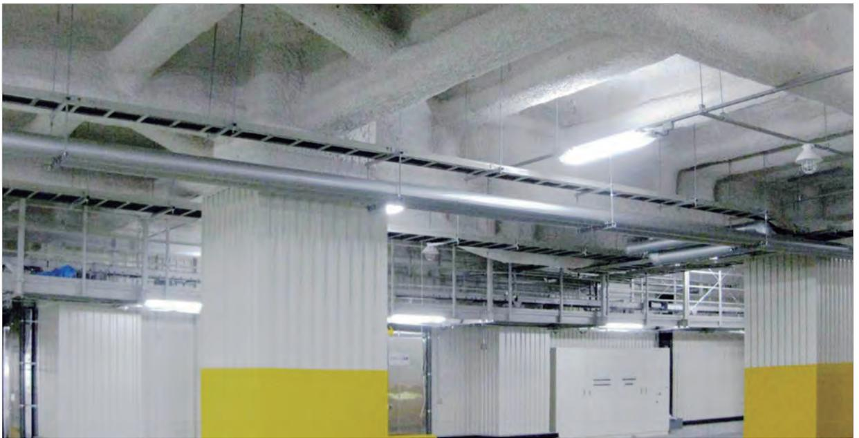
※写真は鉄骨梁に耐火被覆材としてセラタイカ2号を施工後、その上に吹付け硬質ウレタンフォームを施工し、更に内装不燃仕様としてセラタイカ2号を施工しています。（7ページ中段の図を参照）
