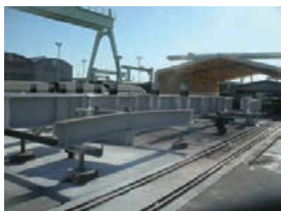
工場プレコート施工
