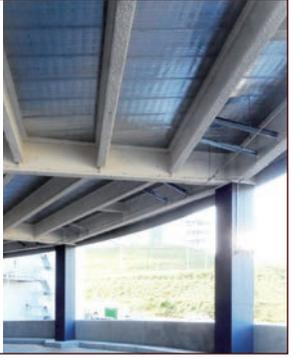
**充填二重鋼管工法**
