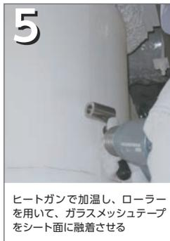
5 ヒートガンで加温し、ローラーを用いて、ガラスメッシュテープをシート面に融着させる
